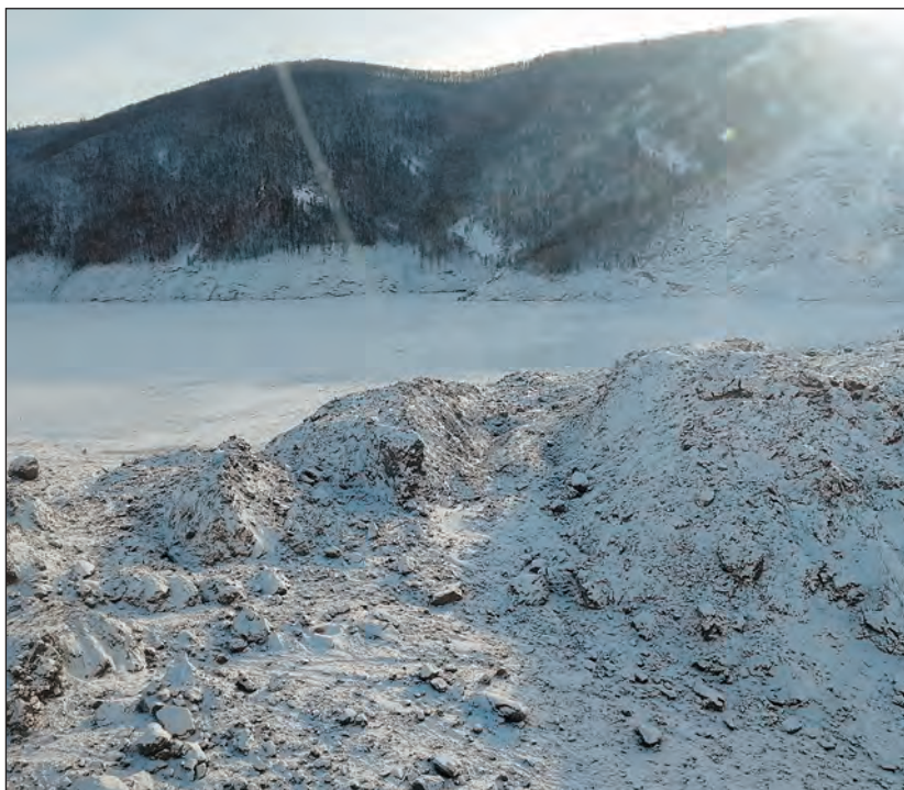
Фронтальная часть оползневого тела.
